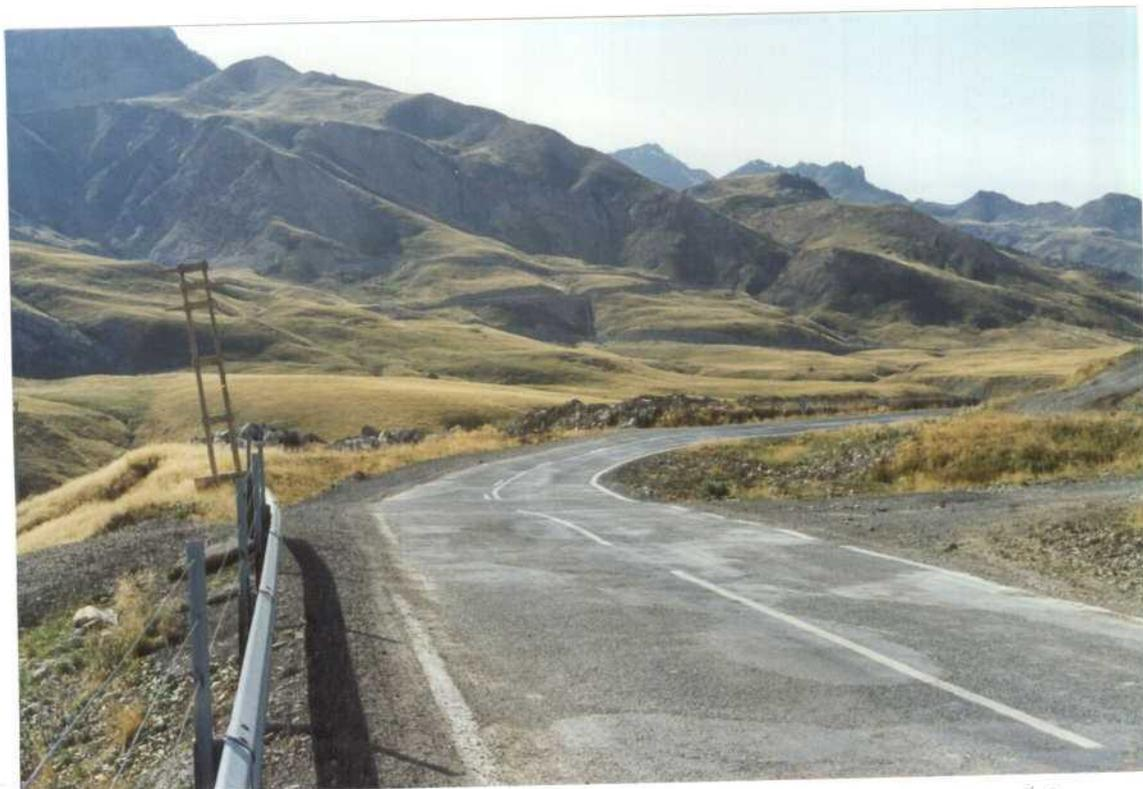
Fotografía n.º 3 .: Detalle de la fuerte curva incrementada por los movimientos superficiales del terreno.
