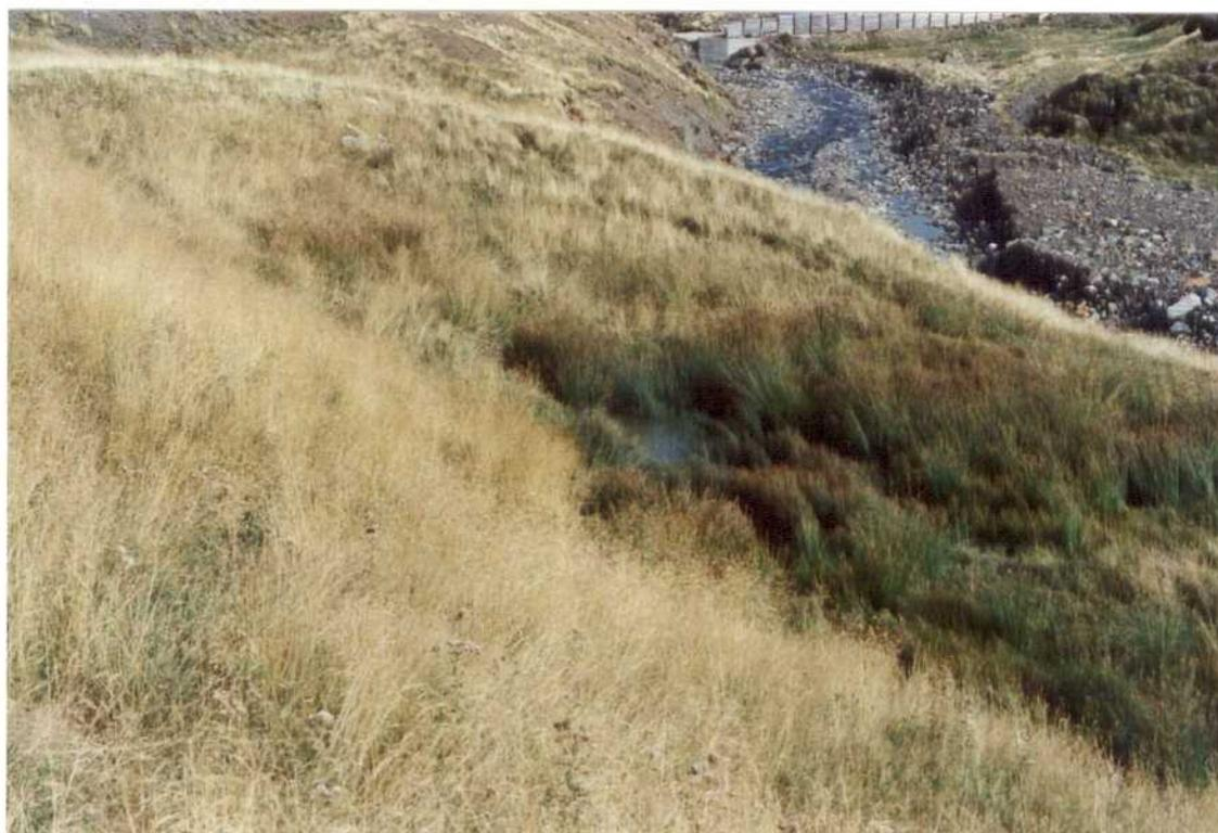
Fotografía n.º 6 .: Afloramiento del nivel freático local. Apréciase como su situación es determinante en relación con la grieta y descalce de la base del talud.
