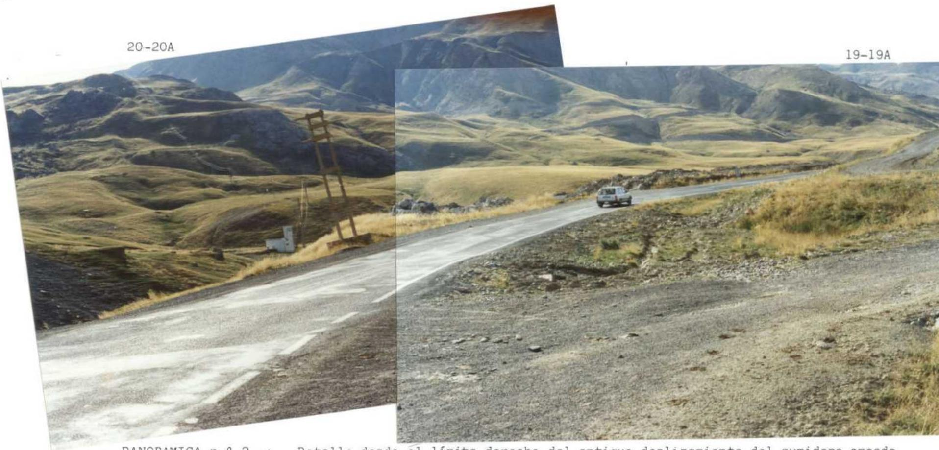
PANORAMICA n.º 2 .: Detalle desde el límite derecho del antiguo deslizamiento del sumidero creado en el interior de la curva. Obsérvese que las escorrentías superficiales de gran parte de la zona superior drenadas por la cuneta interior de la carretera va a acumularse en este punto creando un sumidero que filtra a través del material que constituye el terraplén de la carretera, socavándolo. Véase como los movimientos afectan a un poste doble de hormigón, inclinado hacia el río.
